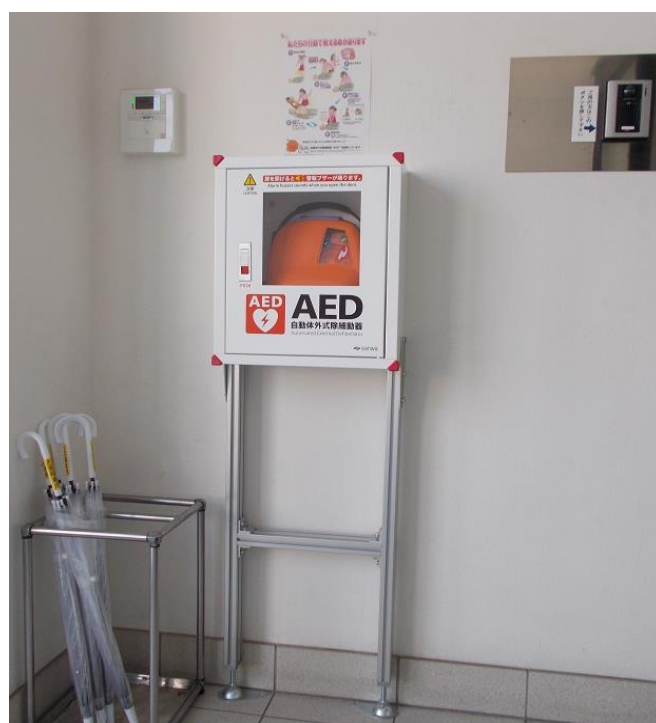
第1棟1F入口
